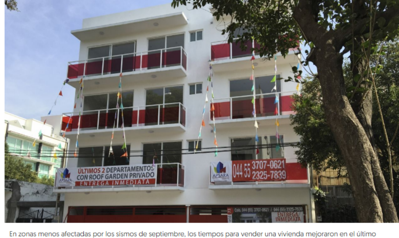
En zonas menos afectadas por los sismos de septiembre, los tiempos para vender una vivienda mejoraron en el último trimestre de 2017. Fuente: Cuartoscuro.
